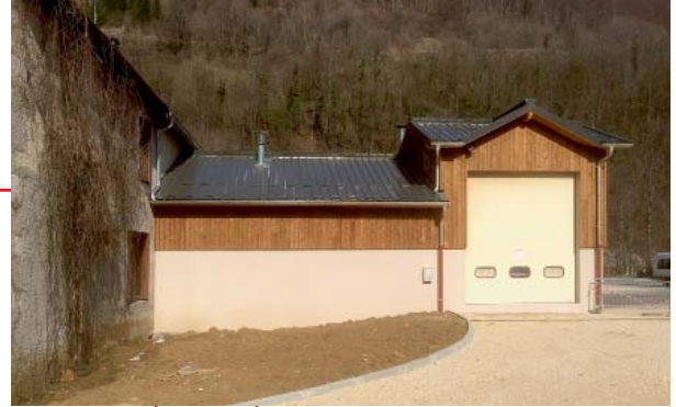
Un projet alimenté par une chaufferie bois
