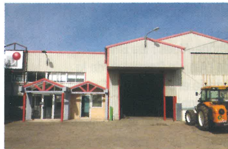
Villereversure : 1 300 habitants. Réhabilitation d'une friche industrielle de 2 500 m 2 de couvert par l'implantation de la bibliothèque municipale, des services techniques, d'un artisan et d'une PME. Gérard Balland est un maire heureux et un fervent supporter de l'EPF.
